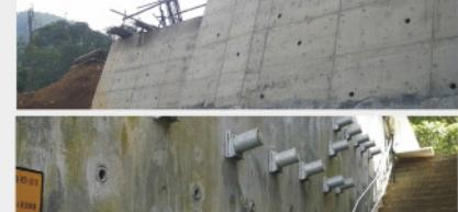
一般常見擋土牆的排水孔，常因現場施工未確實依圖施作，而造成排水孔的排水不順或阻塞，失去了應有的排水防洪功能。甚至肇使擋土牆不堪荷重而導致崩坍，讓可怕的土石流更是雪上加霜。
